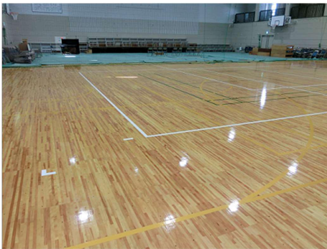
屋内運動場・床改修 既設床サンダー掛け+ポリウレタン塗装
