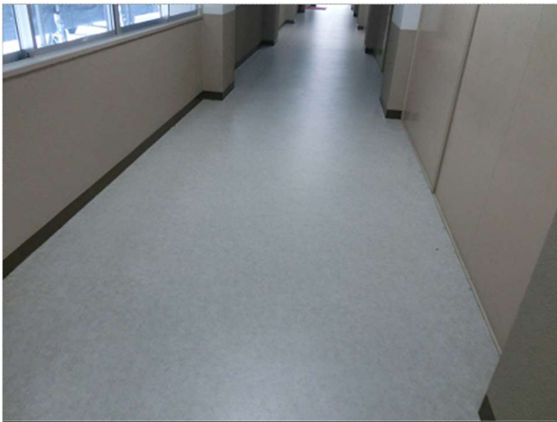
廊下 床:長尺塩ビシート
