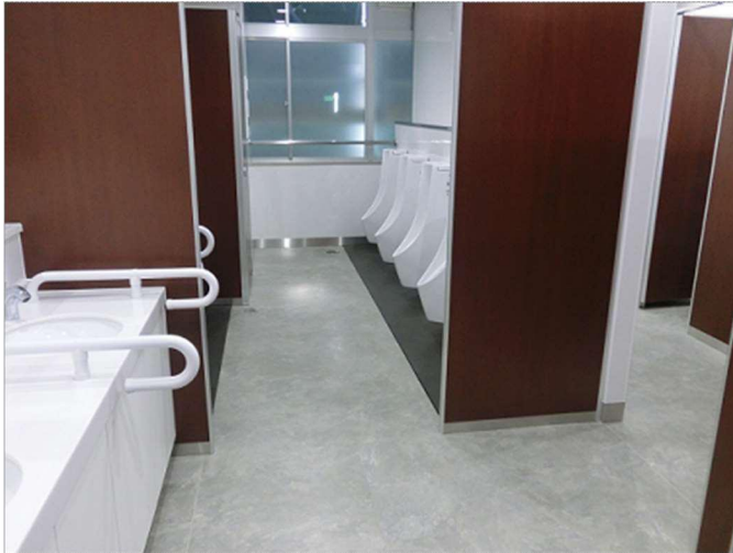
男子トイレ改修
