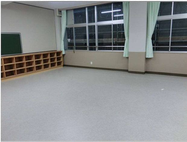
普通教室改修 床:長尺塩ビシート
