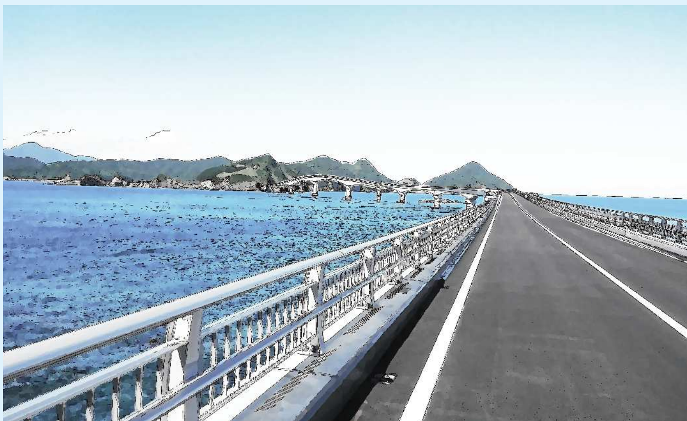
一般県道 鹿島上甑線 甑大橋 (薩摩川内市)
