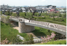
ウッドィタウン・平谷川歩道橋
