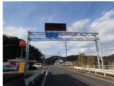
※門型支柱を有する大型の道路標識 及び道路情報提供装置
