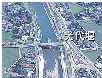
光代堰現況写真
