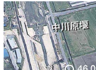
中川原堰現況写真
