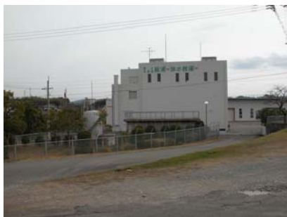
殿浦排水機場
