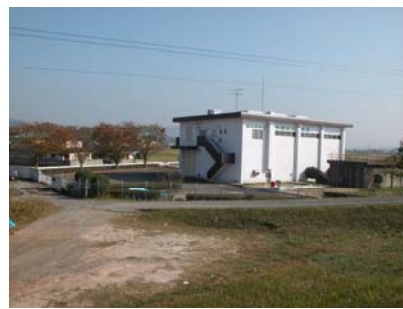
学頭排水機場
