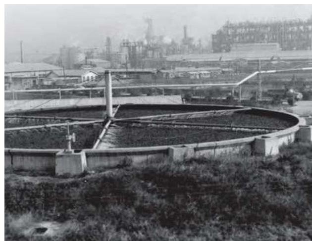
皇后崎下水処理場の散水濾床
