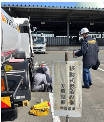
液化石油ガス施設の保安検査
