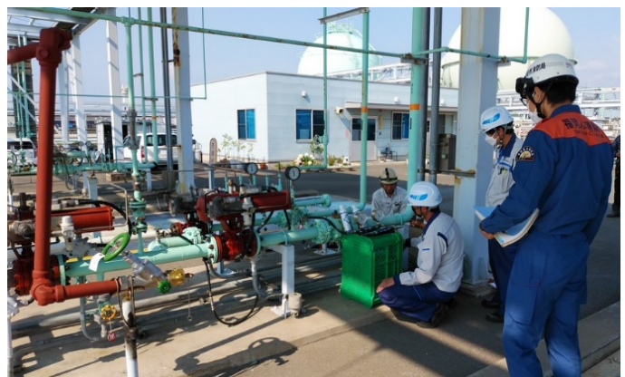
高圧ガス施設の完成検査
