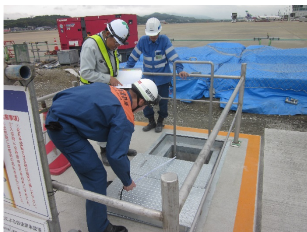
危険物施設の完成検査
