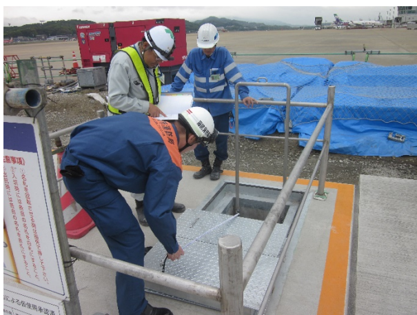
危険物施設の完成検査
