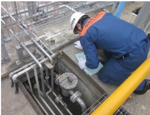
高圧ガス施設の完成検査
