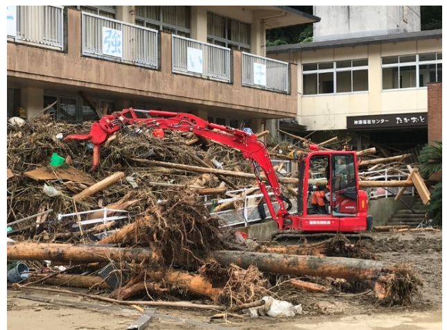
重機を活用した活動
