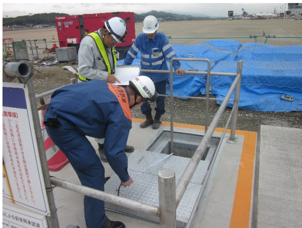
危険物施設の完成検査
