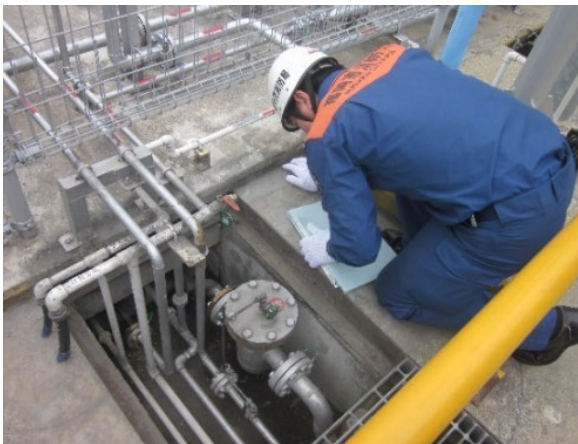
高圧ガス施設の完成検査
