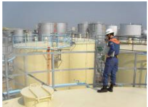
石油コンビナートの立入検査
