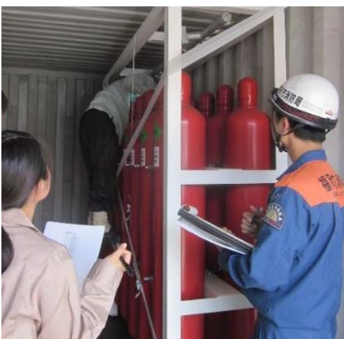
高圧ガスの輸入検査
