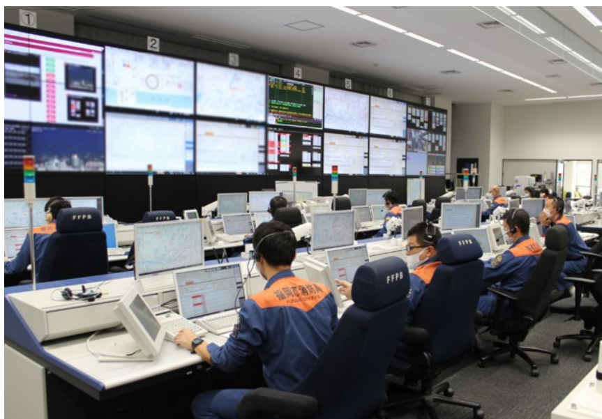
福岡都市圏消防共同指令センター
