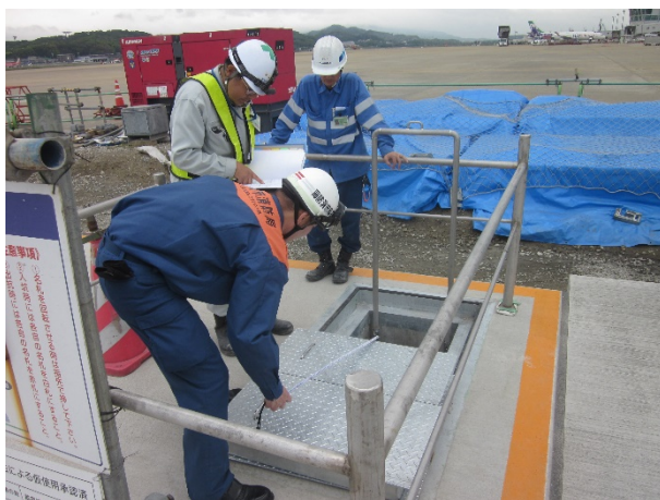
危険物施設の完成検査
