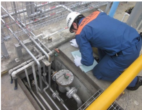
高圧ガス施設の完成検査
