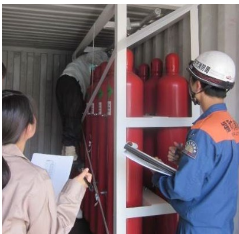
高圧ガスの輸入検査
