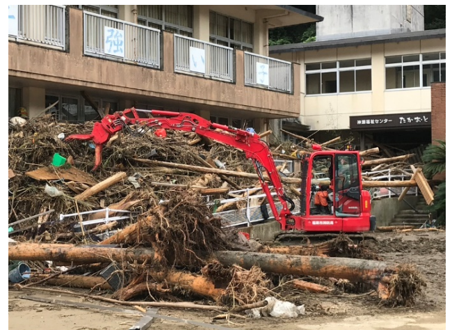
重機を活用した活動
