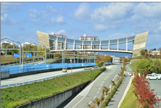
【センチュリー大橋】
