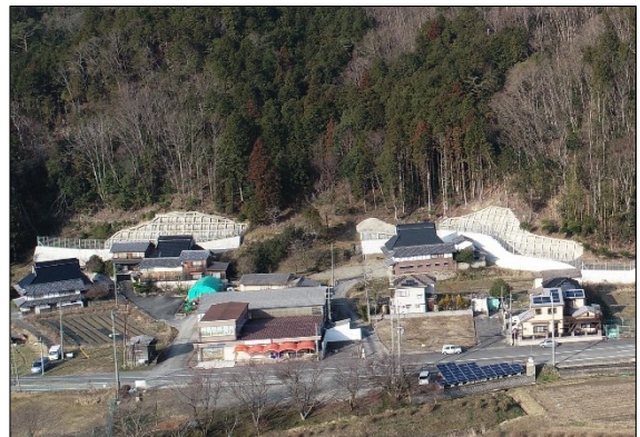
【急傾斜地崩落対策工事(小柿)】
