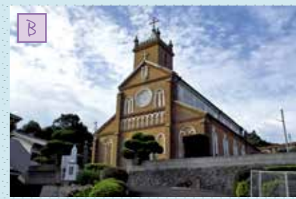
黒島天主堂 大部分がレンガ造りの歴史を感じさせる教会。 国の重要文化財に指定されています。
