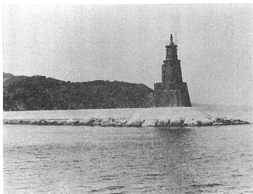
新設された真鶴港灯台（1933年12月）
