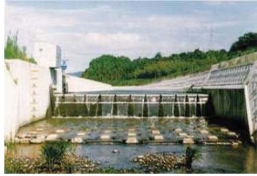
写真 4. 6. 2-3 鋼製起伏堰
