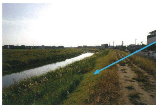
流速が遅いため、堤防に護岸は設置せず、張芝とした。
