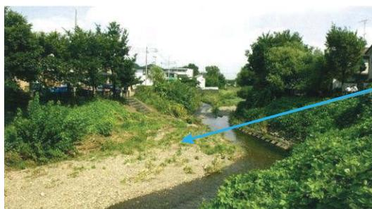
水裏部で前面には砂州(寄洲)が形成されている。ただし、線形と河道特性によっては主流が走る場合もあるため、そういう点についてもチェックし適切に護岸の範囲を検討する。
