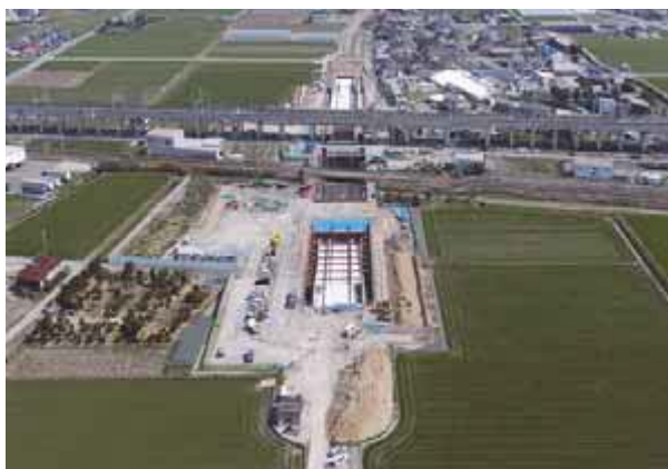
一般県道 柳川筑後線 (筑後市)
