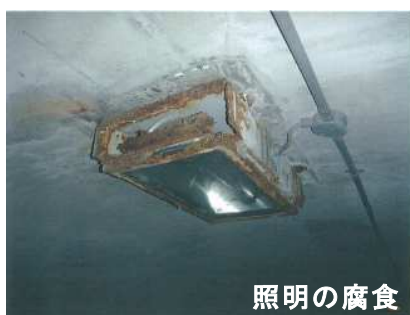
図 1-10 トンネル内附属物の損傷事例
