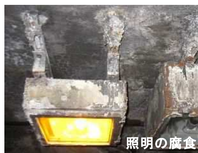
図 1-10 トンネル内附属物の損傷事例
