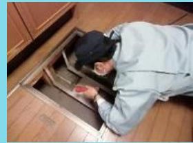
インスペクション（建物現況調査）
