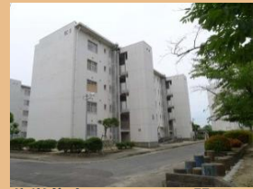
公営住宅へのエレベーター設置
