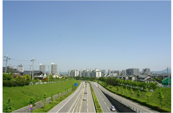
南幹線（フラワータウン）
