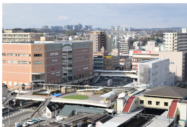
ペDESTリアンデッキ（都市計画道路 駅前1号橋）
