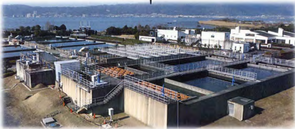
北山田浄水場
