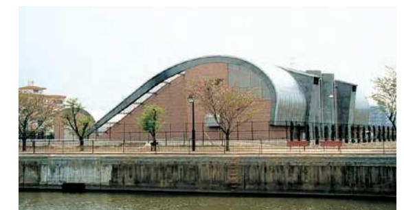
金山川ポンプ場
