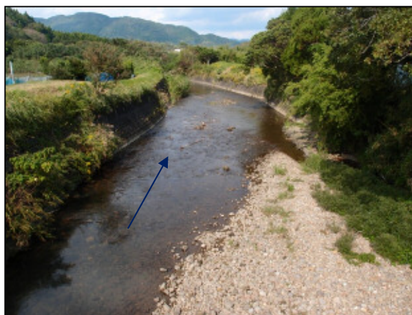
写真 2-1 大浦川現況河道（九玉橋(2/438)より下流の状況）
