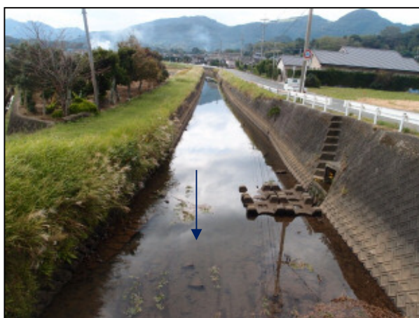
写真 2-2 大王川現況河道（大王橋(0/560)より上流の状況）
