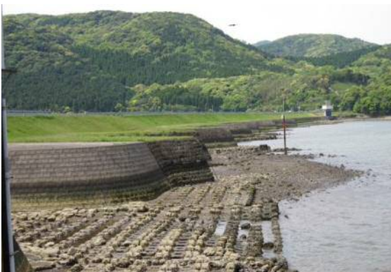
写真 2-18 長崎堤防(写真：薩摩川内市 HP)
