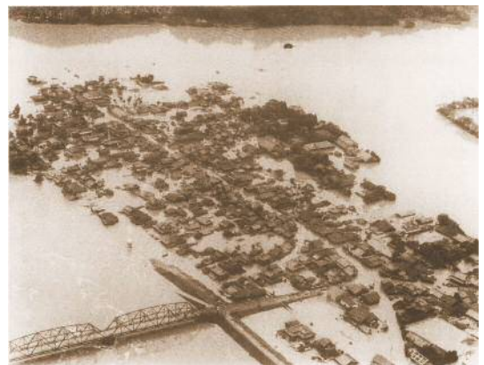
写真 1-7 東郷地区浸水状況 （薩摩川内市）
