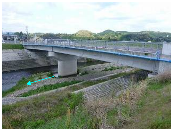
写真 2-9 夜星川橋（整備後）
