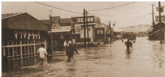
写真 1-11 上川内地区浸水状況（薩摩川内市）
