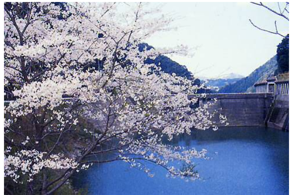
写真 2-19 清浦ダム (写真：川内川河川事務所 HP)
