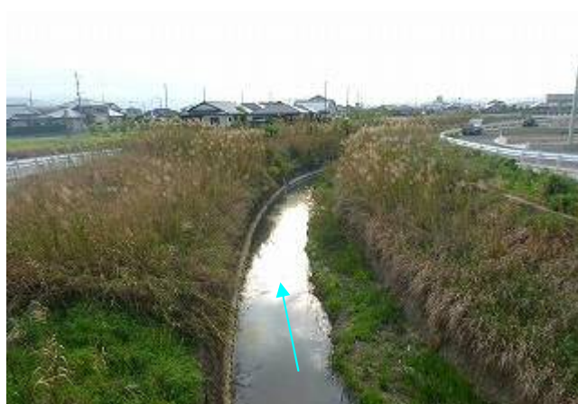
写真 2-4 三堂橋から下流を望む
