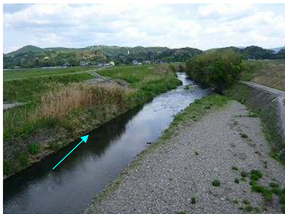
写真 2-8 夜星川橋より下流望む（整備後）
