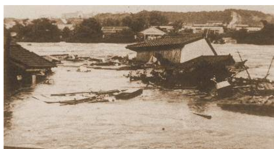
写真 1-14 家屋流出状況（さつま町）
