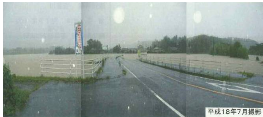
写真 2-7 浸水状況（H18.7：夜星川橋）
