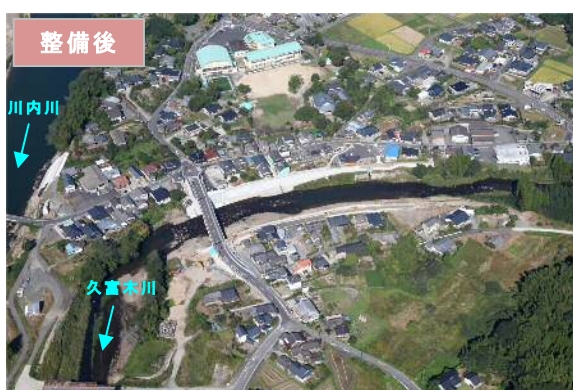
写真 1-4 久富木川における整備状況
