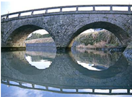
写真 2-22 江之口橋(写真：薩摩川内市 HP)
