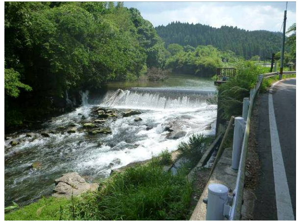
写真 2.2-2 溝之口川の取水状況
