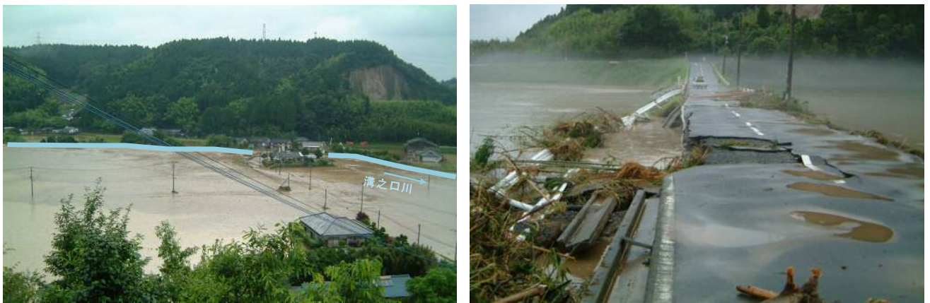
写真 1-1 平成 22 年 7 月洪水被害の状況
