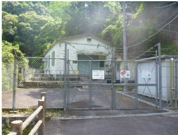
写真 2.2-3 溝之口川の発電所（溝之口発電所）
