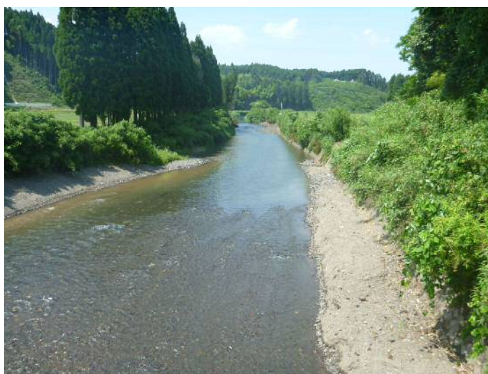
写真 2.1 庄内川：堤橋周辺の河床掘削の状況
