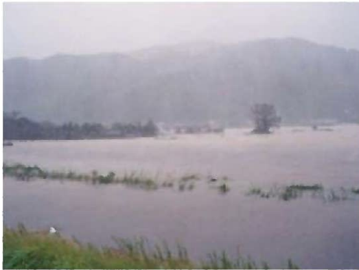
写真 1-7 肝属川 2k000 付近 堤内地浸水状況
