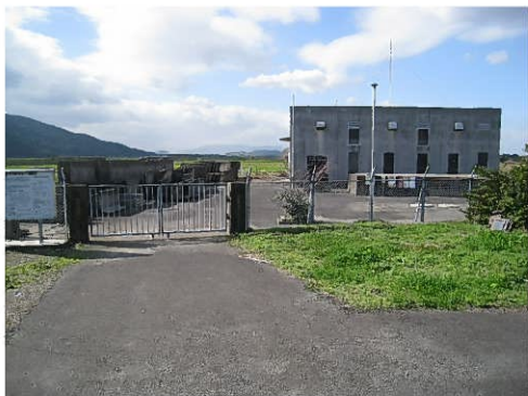
写真 2-4 港原排水機場 (東串良町新川西)
