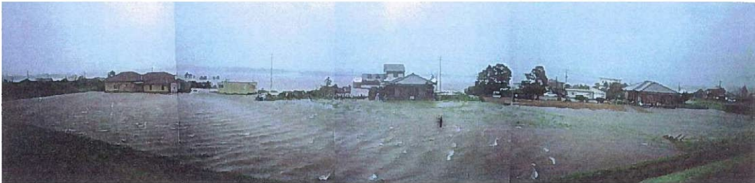
写真 1-11 肝属川右岸 8k600 付近 堤内地浸水状況
