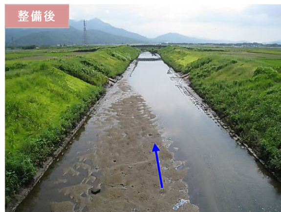
写真 1-2 塩入川の河川整備状況 〔中園橋(2k380)下流〕
