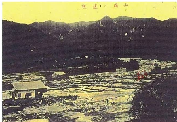
写真 1-4 肝付町後田方野付近被害状況
