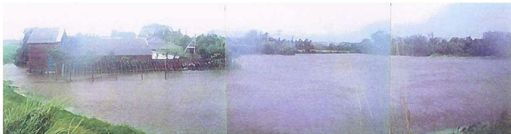
写真 1-12 串良川左岸 0k600 付近 堤内地浸水状況
