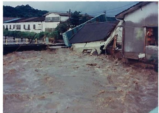
写真 1-6 下谷川 0k200 付近 (田崎橋下流左岸)被害状況
