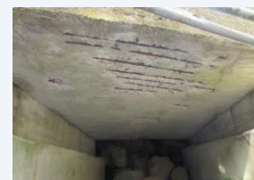
【橋りょう】第3畑橋(菊池市)の補修
