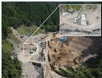
【砂防】川内川(球磨村)砂防堰堤整備
