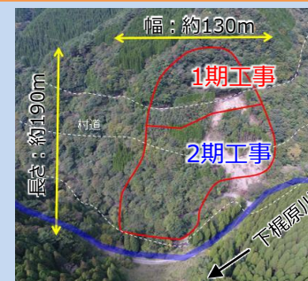
被災箇所の全景（平成29年撮影）
