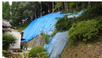
土砂災害発生おそれ
