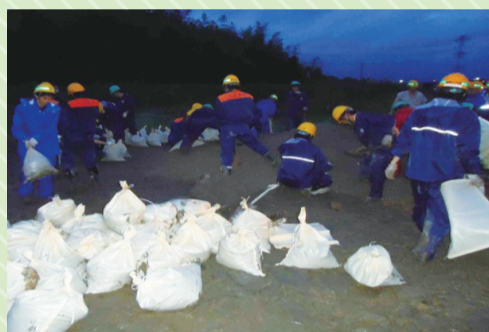
土のう作業の様子(台風15号時)
