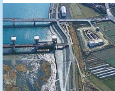
平成大堰 平成 2年度完成
