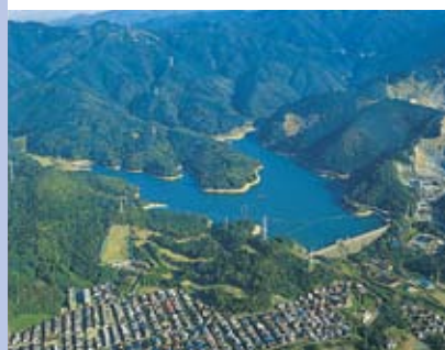
かたまり貯水池 昭和30年度完成
