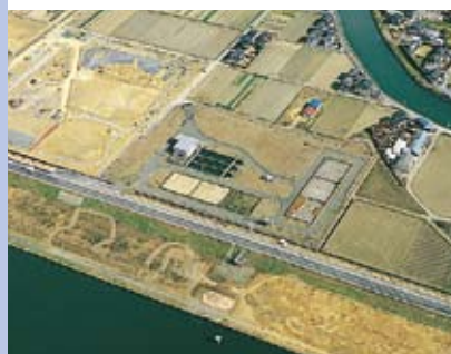
猪熊取水場 昭和57年度完成
