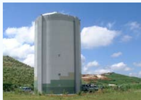
平尾台配水池
