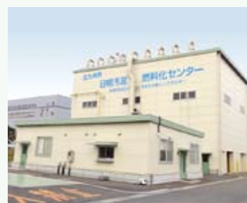
日明汚泥燃料化センター
