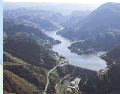
耶馬溪貯水池 昭和60年度完成
