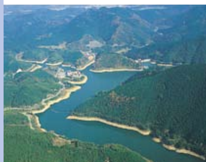
かたまり貯水池 昭和40年度完成
