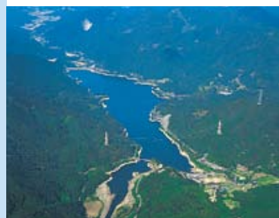
油木貯水池 昭和46年度完成
