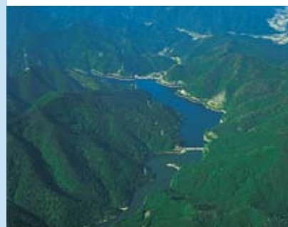
ます淵貯水池 昭和48年度完成
