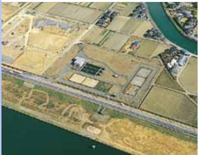
猪熊取水場 昭和57年度完成
