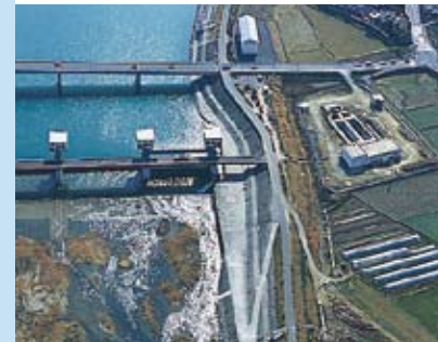
平成大堰 平成 2年度完成
