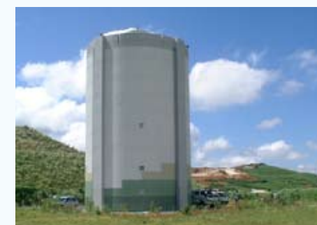
平尾台配水池
