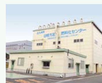
日明汚泥燃料化センター
