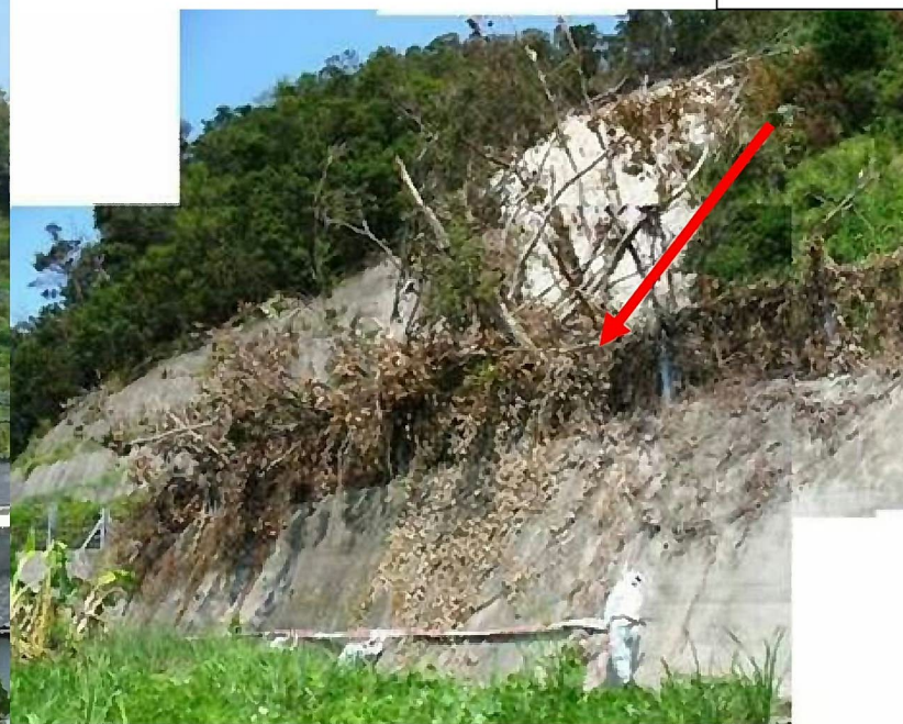
崩壊土砂捕捉状況
