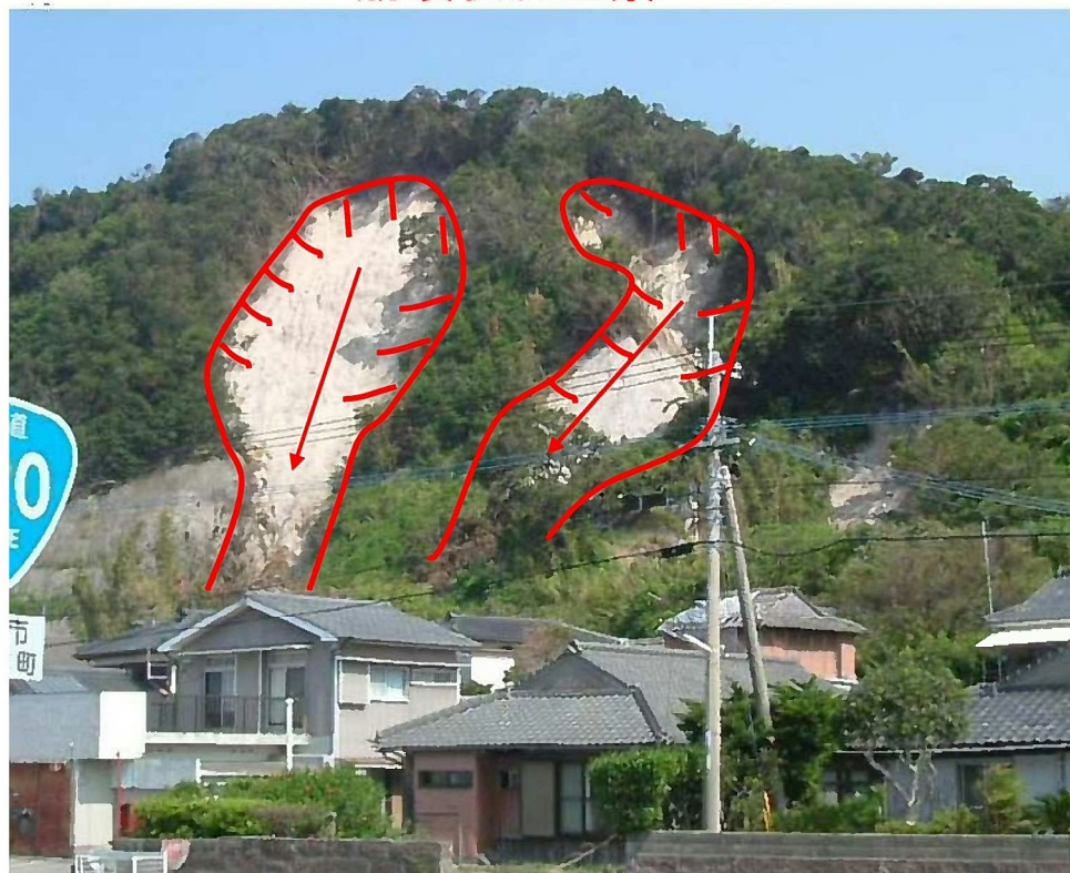
崩壊状況全景
