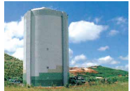
平尾台配水池
