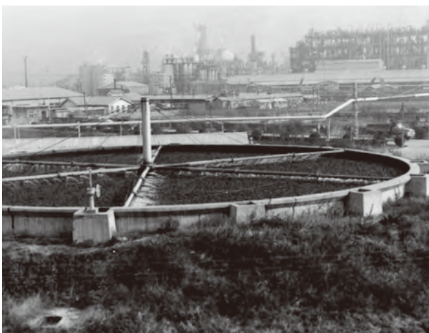
皇后崎下水処理場の散水濾床
