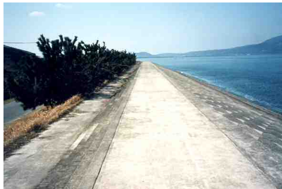
緩傾斜護岸と松林(出水海岸)
