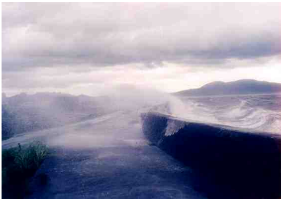
越波による被害1 (出水市)
