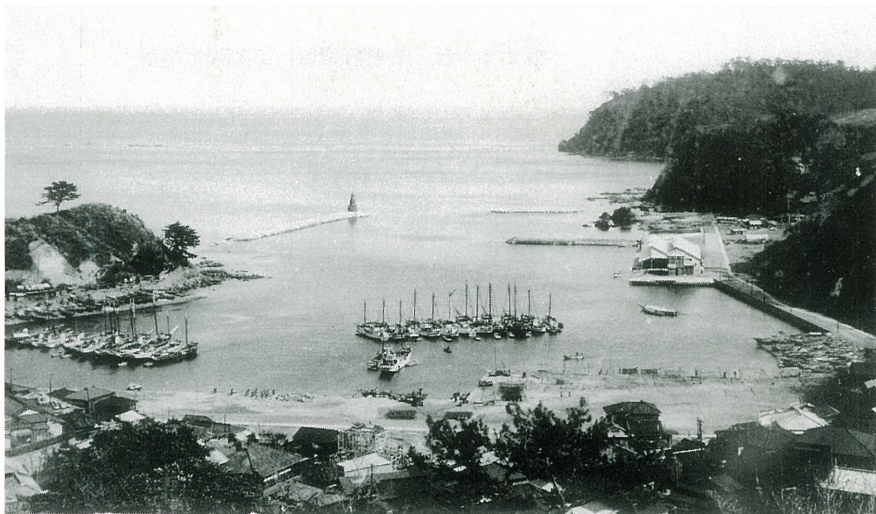
昭和9年 完成した真鶴港
