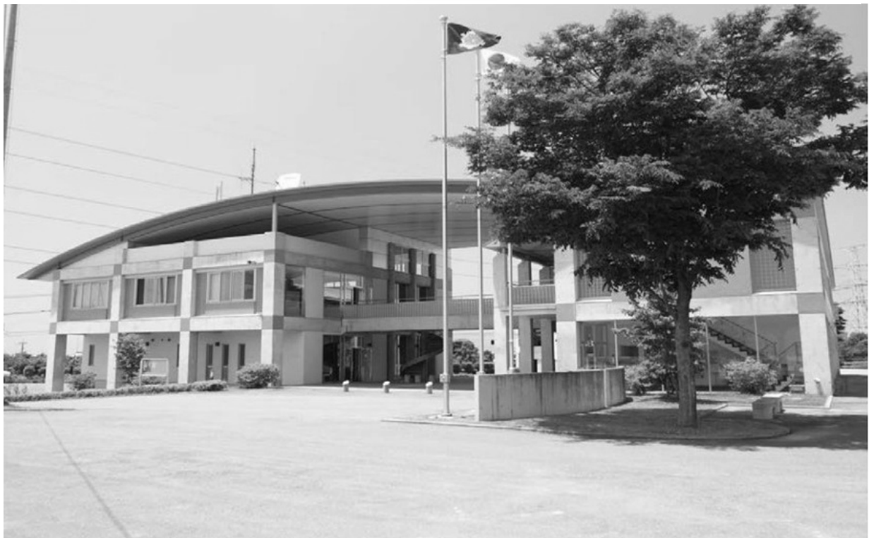
益城西原消防署（旧高遊原南消防組合消防本部）
