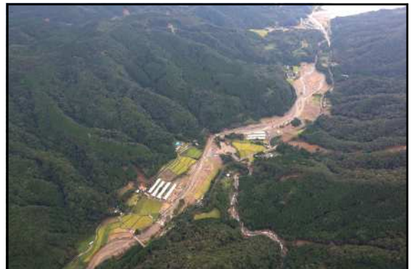
平成28年台風16号による串良川災害
