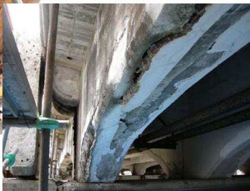
塩害による損傷の例
