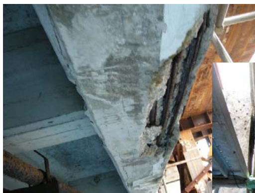
塩害による損傷の例
