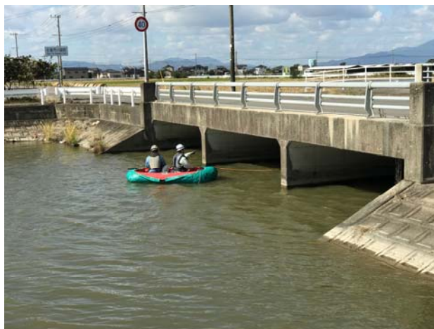
「ボート」による近接目視
