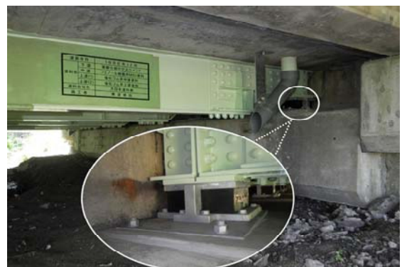
対策後：支承の取替え
