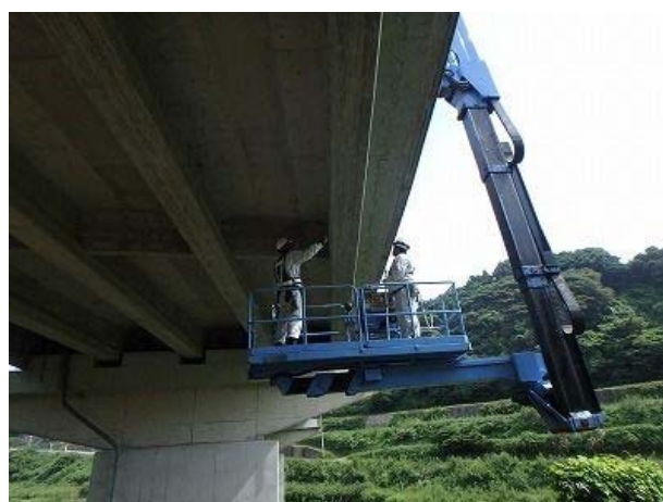
「橋梁点検車」による近接目視
