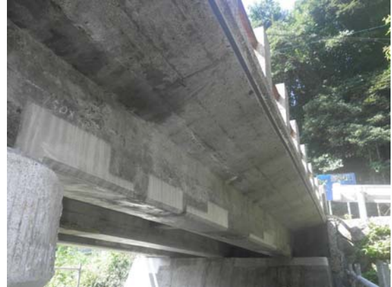
対策後：断面修復
