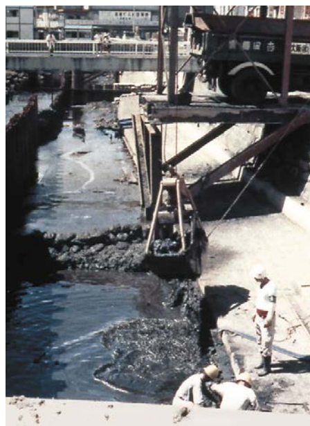
おおむたがわ 大牟田川の底にたまった ヘドロを取りのぞく様子
