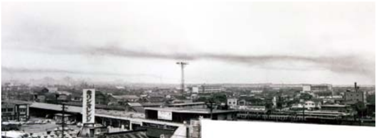
大牟田市役所屋上から西方(大牟田駅側)をのぞむ(ばいじんが上空をただよっている)
