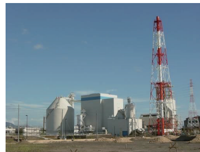
大牟田リサイクル発電所
