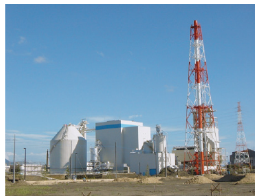
大牟田リサイクル発電所
