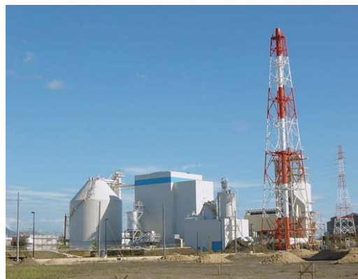
大牟田リサイクル発電所
