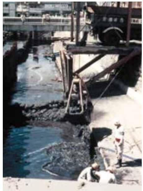
おおむたがわ 大牟田川の底にたまった へドロを取りのぞく様子
