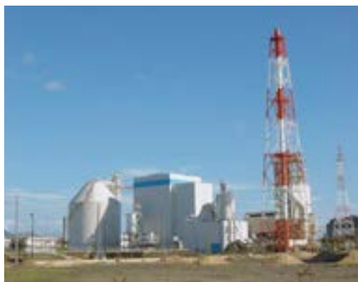
大牟田リサイクル発電所
