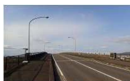
橋梁補修 向江跨線橋工区
