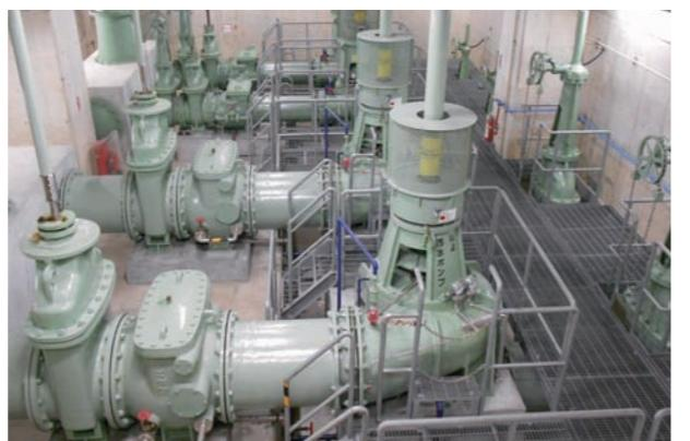
下水管のと中にポンプ場をつくって、よごれた水をくみ上げ、浄化センターへ流れるようにしています。
