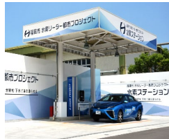
▲ 水素ステーション
